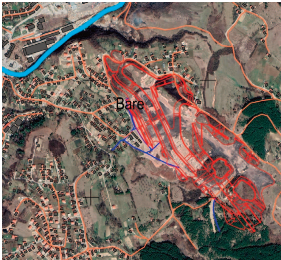
Slika 10. Satelitski snimak izvedenih radova na odlagalištu „Bare“
