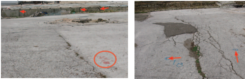
Slika 4. Lijevo: Poligonska tačka AM3 sa trasom pružanja ožiljka okomito na porušeni objekat "Amosa".
