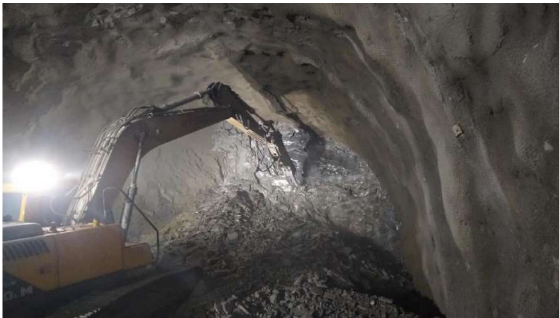
Slika 6. Strojni iskop punog presjeka u LTT na stacionaži 1+518,00 do 1+520
