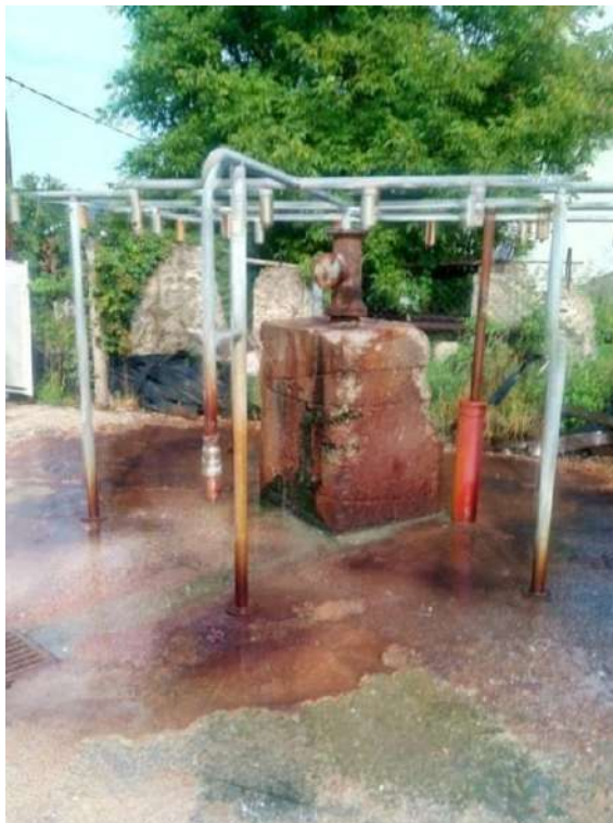
Slika 3. Izgled ušća bušotine SI-1 u Slavinovićima, sa konstrukcijom cijevnog razdjelnika (tuševi) (Foto: Nuhanović, S; Barušić, B., 2020.)
