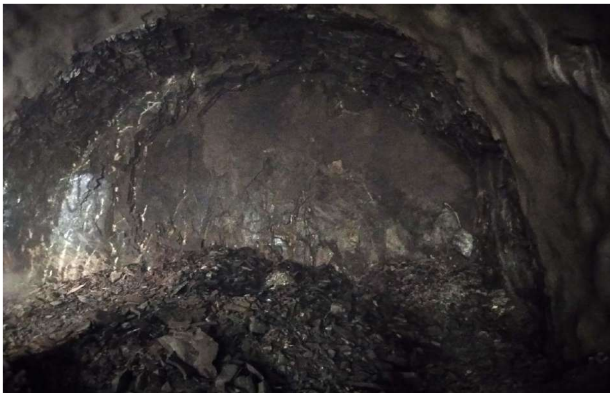
Slika 10. LTT presjek čela na stacionaži 1+524.088 nakon miniranja i obrade poprečnog presjeka
