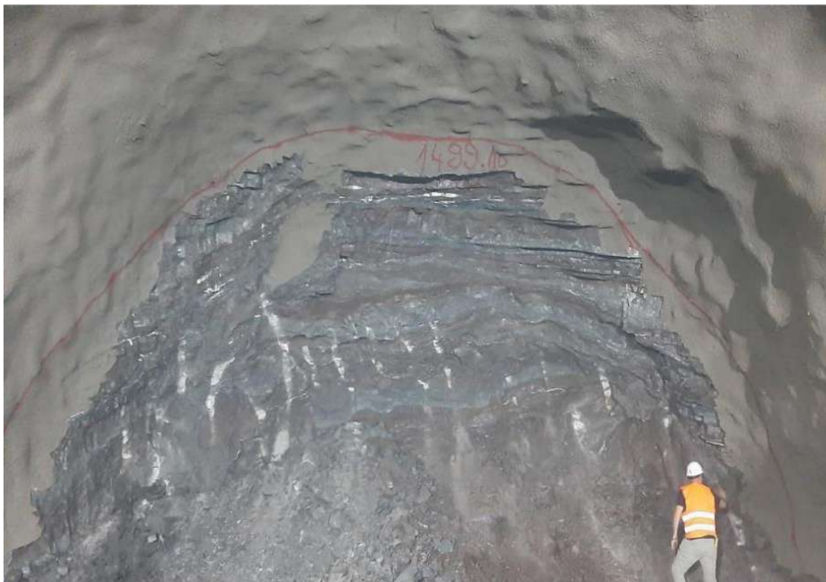
Slika 2. Prikaz radne površine, stacionaža 1+499.10 - lijevi tunel
