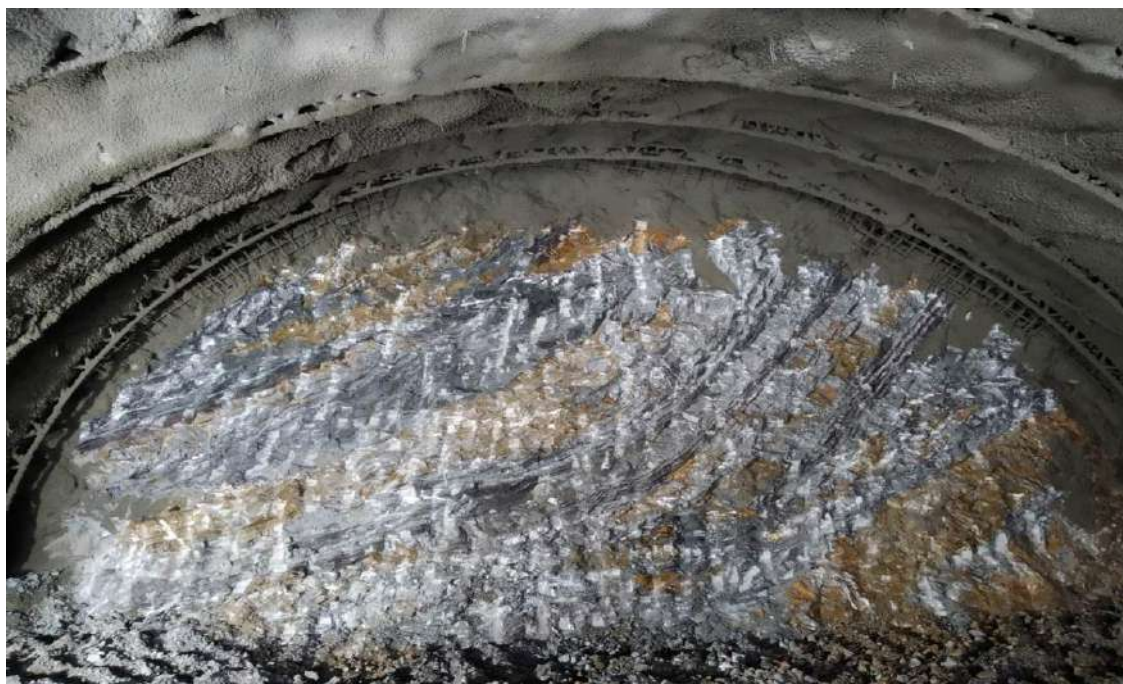
Slika 1. Čelo iskopa tunela Zenica
