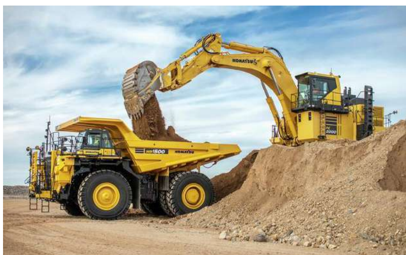
Slika 3. Utovar materijala hidrauličnim bagerom sa obrnutom kašikom u kamion – donje kopanje
