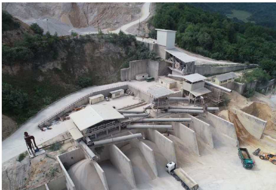
Slika 6. Postrojenje za drobljenje i klasiranje dolomina na kamenolomu Plješevac
