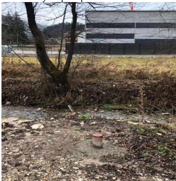
Slika 3. Prikaz ugrađenog–zaštićenog pijezometra
